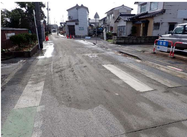
液状化現象により土砂が噴出
