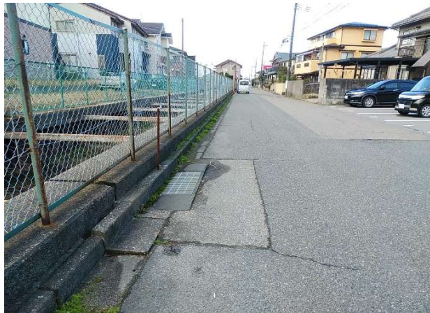
排水路自体は異常なし
