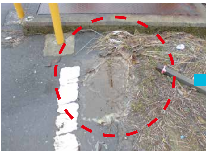
歩道に埋設されたφ1200の用水管より漏水
