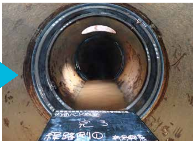
内面止水バンドφ1200により補修完了
