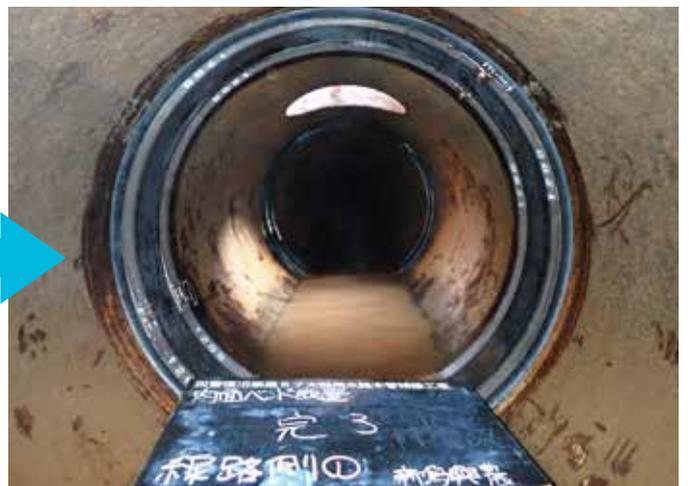
内面止水バンドφ1200により補修完了
