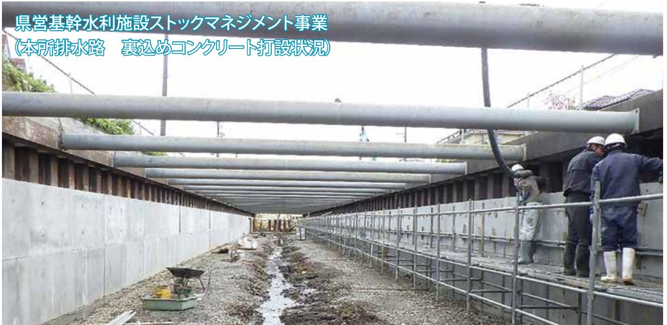
県営基幹水利施設ストックマネジメント事業 (本所排水路 コンクリートパネル設置状況)
