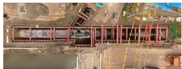
県営地盤沈下対策事業 阿賀幹線用水路第71次工事 本管布設状況
