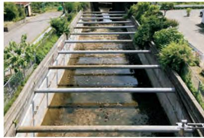
県営基幹水利施設ストックマネジメント事業 亀田郷地区 防食処理工法(コンクリートパネル)で補修した本所排水路
