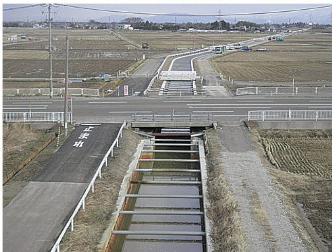
県営流域水質保全機能増進事業：H26年度で完了した大淵排水路
