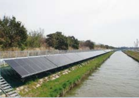
小松堀排水路 太陽光発電施設建設工事
