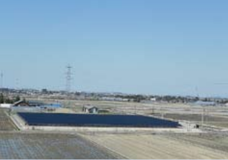
松山地内 太陽光発電施設建設工事
