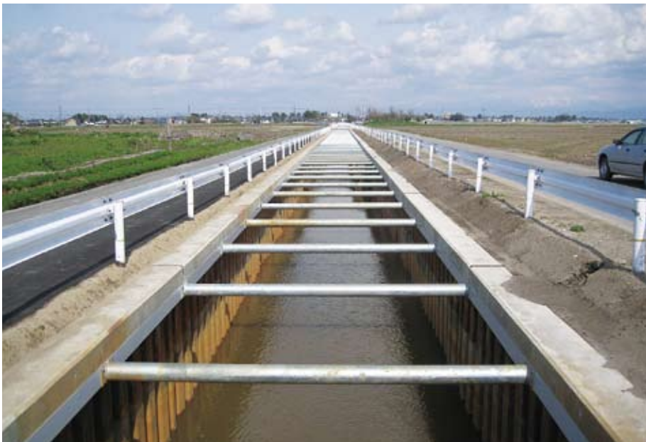
県営流域水質保全機能増進事業で改修された大沢排水路
