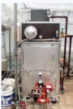
施設工業株の協力で、廃油をそのまま燃やすことができるボイラーを、試験用の高性能先進型農業用ハウスに導入しました。今まで廃油を燃料にするには重油に混ぜたり、精製したりと、手間と時間が必要でした。新技術では「ゴミを取るだけで簡単に燃焼し煙も出なくなりました。食用廃油、工業用廃油、新品の灯油、重油を単独でも混ぜても使用できる優れものです。この冬には性能をデータ化します。
