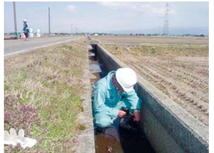
小杉下での補修作業
