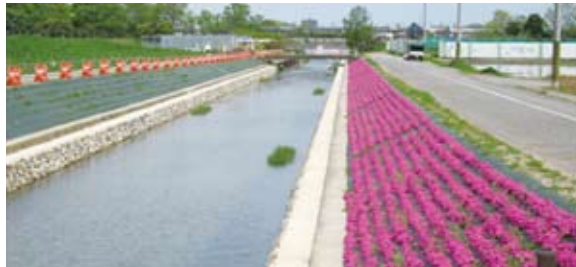
(平成21年度)県営かんがい排水事業による清五郎排水路の整備
