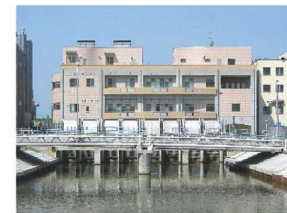
⑧ 排水の要となる親松排水機場
