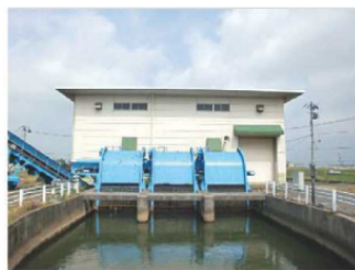
① 取水源となる舞潟揚水機場
